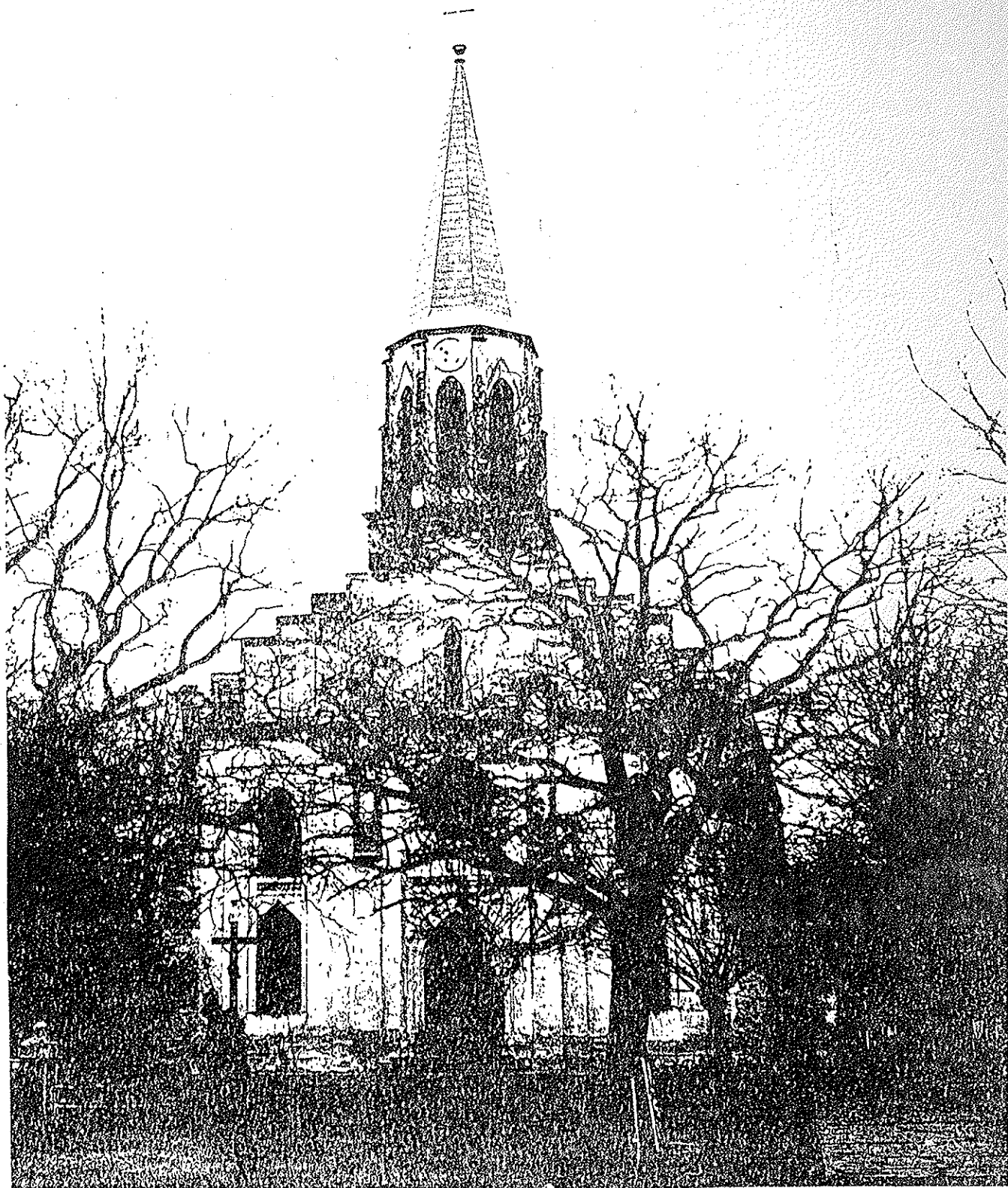
Földeáki katolikus templom, épült 1854 - 1857.években Oltványi Pál plébános közbejárásával /Megyesi János nagyitása/
